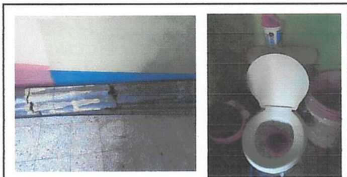
6. Levantamiento de piso de granito, compactacion de terreno y aplicado de concreto para posterior colocar piso ceramico. 7. Cambio de sanitario y reparacion de drenaje.
