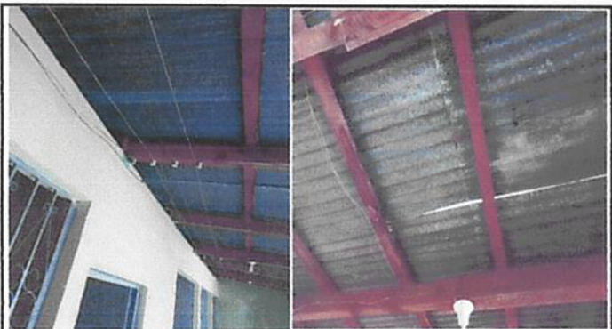
3. Cambio de cableado electrico e iluminacion.
